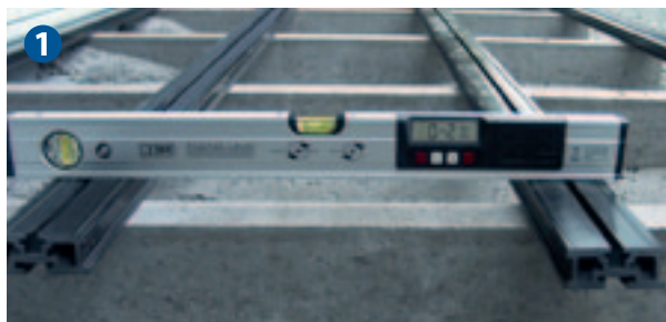
1 Untergrund vorbereiten und Unterkonstruktion befestigen.
